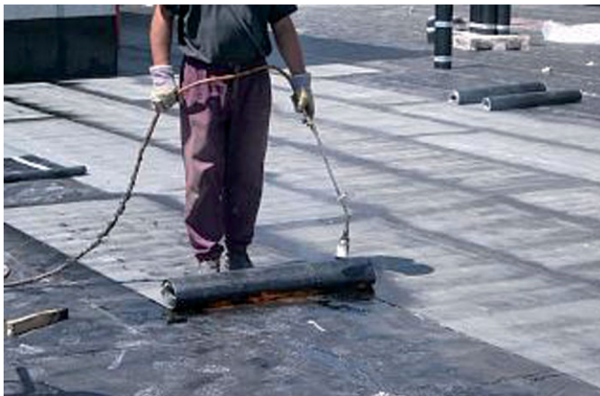
Bild 4. Eine weitere Lage BÖRNER Polymerbitumen-Schweißbahn, deren Qualität sich am späteren Aufbau (Bekiesung, Begrünung, Plattenbelag, etc.) orientiert, wird als Oberlage im Schweißverfahren ebenfalls vollflächig aufgebracht (Grafik/Fotos: puren)
