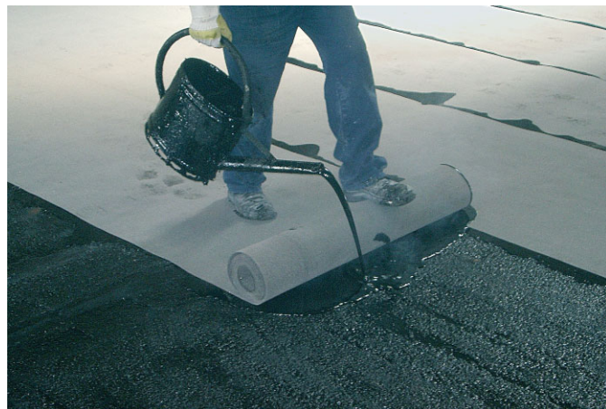
Bild 2. Dampfsperre aus Polymerbitumen-Dachdichtungsbahnen: vollflächiges Aufkleben der Börner Dampfsperre im puren PIR KOMPAKT Sicherheitsdach mit heißflüssigem WIROBIT KOMPAKT Elastomerbitumen auf den Betonuntergrund
