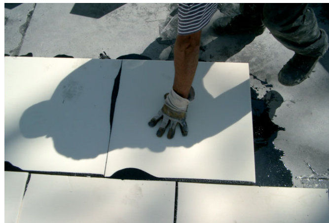
Bild 3. Aufkleben der puren PIR KOMPAKT SD Dämmplatten: vollflächiges und vollfugiges Aufkleben der puren PIR KOMPAKT SD + Dämmplatten in WIROBIT KOMPAKT Elastomerbitumen auf die Dampfsperre
